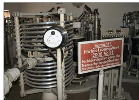
Bild 15: 100-kW-Mittelwellensender Hamburg Billwerder-Moorfleet Fotos: DL2MCD
