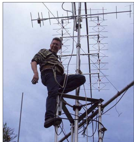
DF1JM bei Arbeiten am Mast
